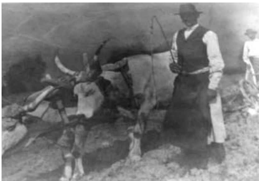
Néhai iskolások szántás közben • A szerző archívumából
