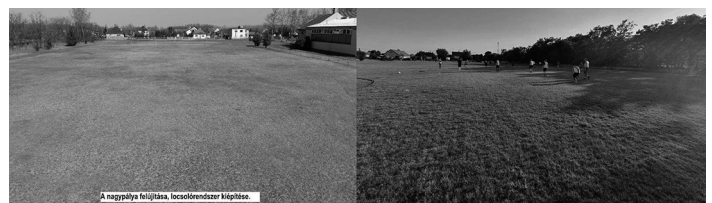
A nagypálya felújítása, locsolórendszer kiépítése.
