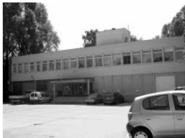
7. kép: A központi bányamentő állomás új épülete
