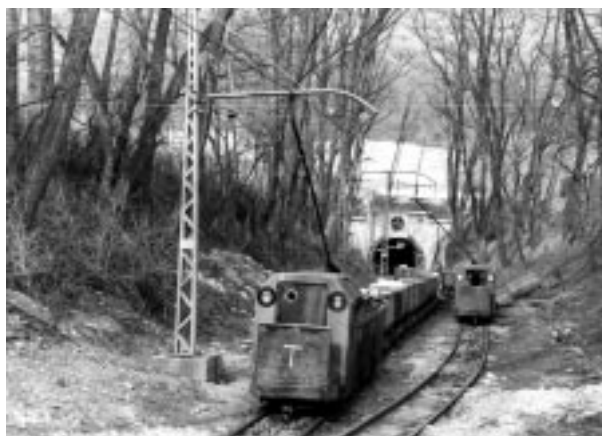
7. ábra: A Borókási-altáró 1987-ben (Hosszú Lajos)
