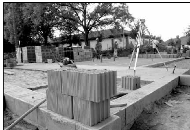
Ez a számítógép nélküli valóság: megkezdődött a falak építése
