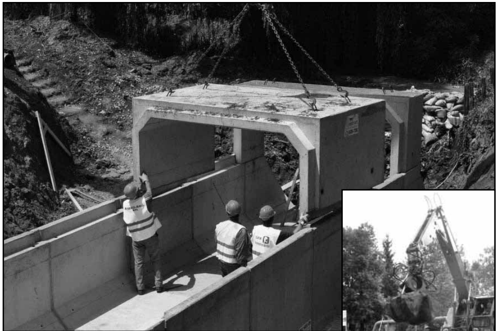
Híd építés a Vár utcánál
