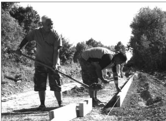
A kerékpárút alapját készítik
