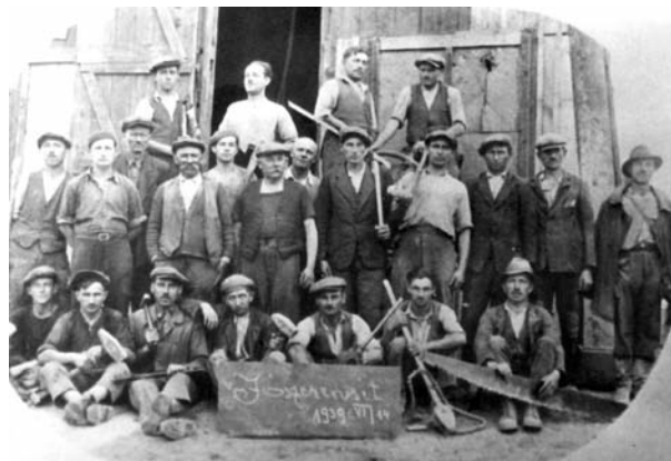
3. kép: Komló Bánya, Újlégakna átfalazása (1939)
