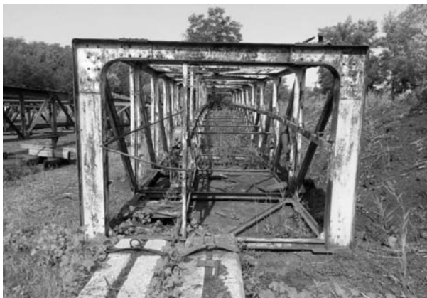
1. ábra: A szalaghíd
