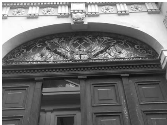
7. kép: A bejárat fölötti díszrácsoszat
