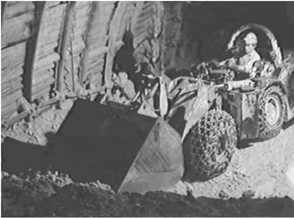
4. ábra: Eimco 911 B rakodó gép
