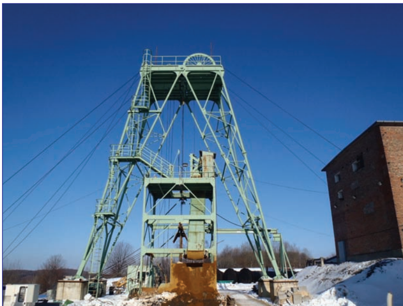
Mátraszentimrei aknatorony, döntőberendezéssel
