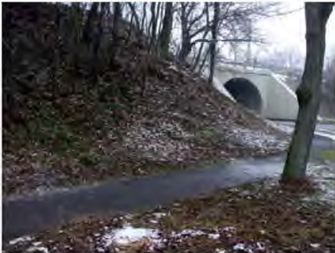
Aligai vasútállomás felhajtó kitisztítása
