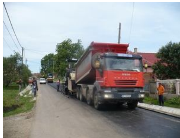
A HEGYKÖZCSATÁRI KIS UTCÁBAN HELYEZIK FEL AZ ÚTTESTRE A KOPTATÓ BÚRKOLATOT
