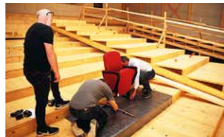
Épül a nézőtér
