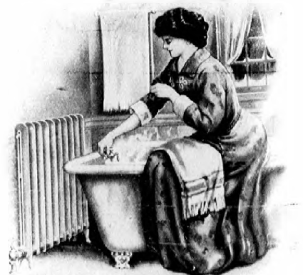
Heisswasser im Badezimmer.
