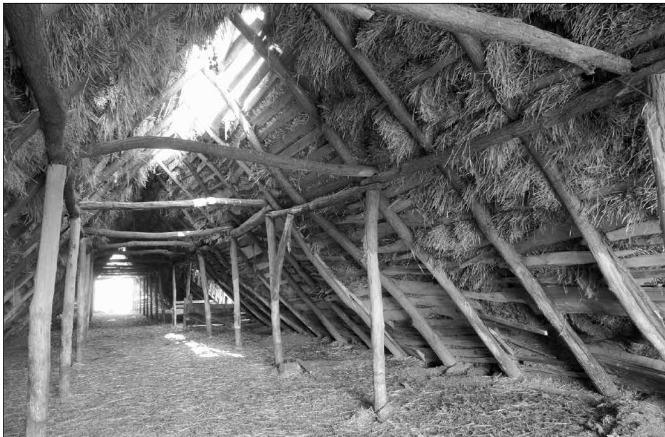
Juhhodály a tavaszi „reparálás” előtt. Ahol nincs nádas, ott szalmával borítják az építmény gerendavázát. (Báránd, 2005)
