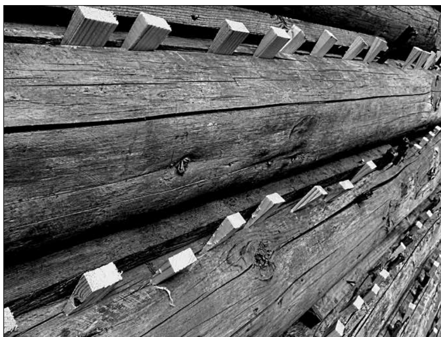
■ 5. kép: A tapasztást megtartó bolhaszegek ■ Photo 5. Pegs holding the plaster in place
