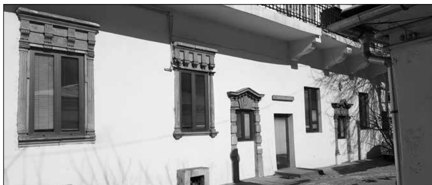
■ Foto. 3. Imagine actuală cu fațada dinspre curte, ancadramente de fereastră și ușă din perioada István KAKAS © Sabin FĂRCAȘ
