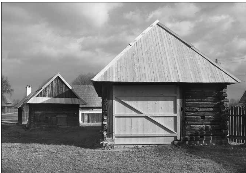
■ 3. kép: A „védtelen” faanyag gyors felületi szürkülése gyors illeszkedést tesz lehetővé ■ Photo 3. The quick greying of the surface of unprotected wood enables quick fitting
