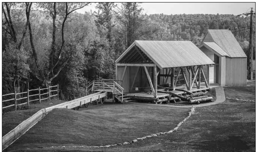
■ 9. kép: Az ivói vízfűrész építésénél a mestereknek (újra) kellett tanítani a fizikai faanyagvédelmet ■ Photo 9. At the construction of the water-powered sawmill in Izvoare, the physical protection of the wood had to be (re)taught to the craftsmen
