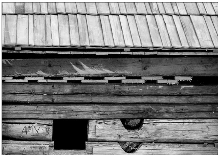
■ 4. kép: Gyakorlatilag minden fából készült a malmon. A falszerkezet a tapasztás előtt ■ Photo 4. Practically everything is made of wood in the mill. The wall structure before plastering
