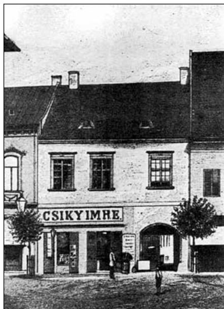
■ Fig. 2. Desen după o fotografie de epocă, realizată de Ferenc VERESS în 1859-1860, reprezentând Casa Wolphard-Kakas (BALOGH 1985, fig. 121)
