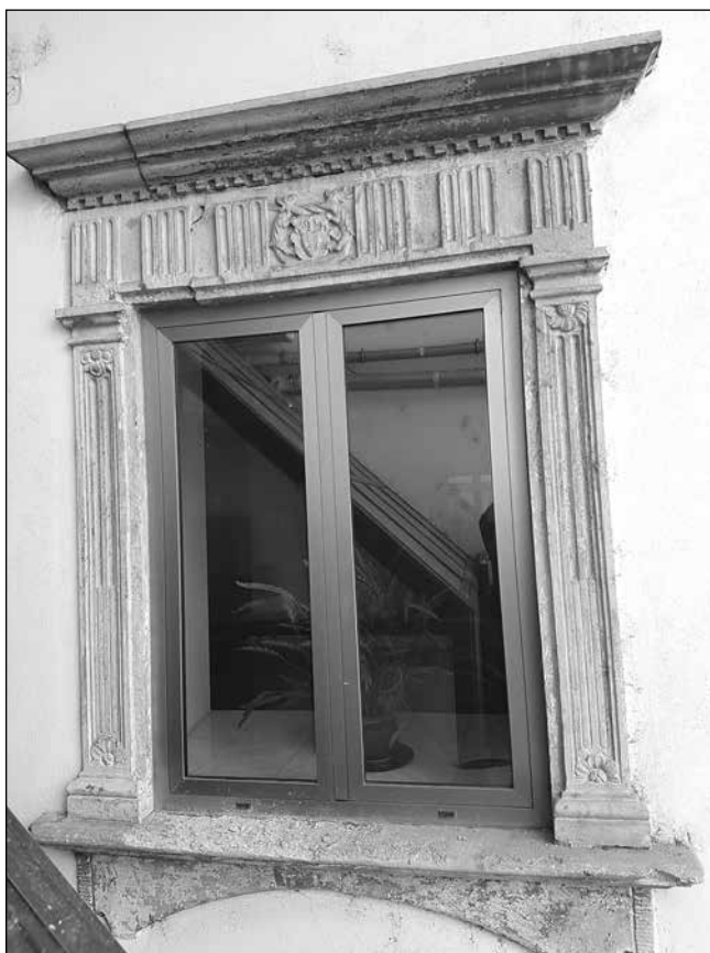
■ Foto. 5. Ancadrament de fereastră realizat între 1576-1579, perioada Stephan WOLPHARD, existent pe fațada dinspre curte, ancadramentul situat deasupra intrării boltite de acces către pivniță © Sabin FĂRCAȘ
