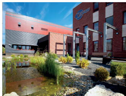
EGIS, BÖKENYFÖLDI ÚT
