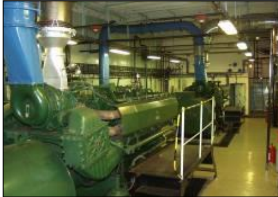
6. kép. 2X8 hengeres Diesel motor [11]
