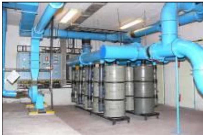
4. kép. WC- csoport szellőző rendszere [9]
