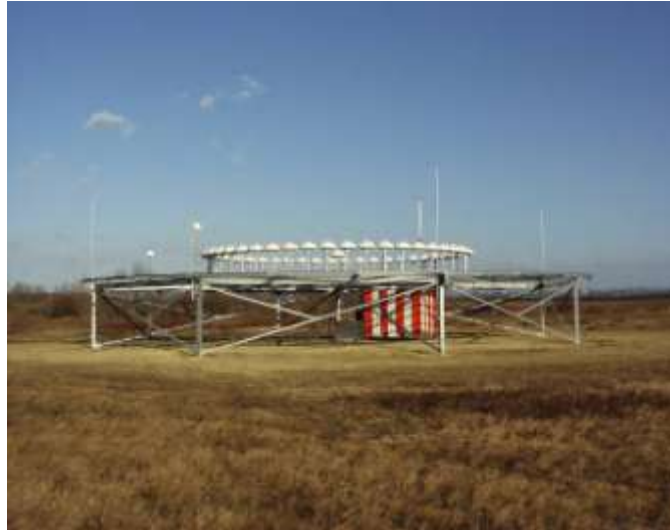
9. ábra. DVOR/DME berendezés, villámvédelmi felfogókkal
