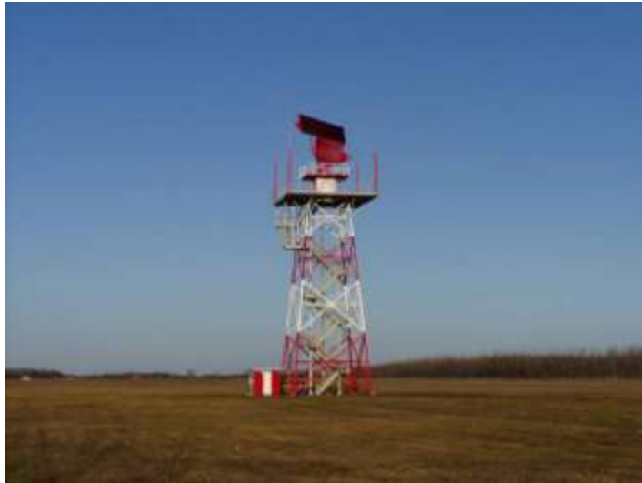
5. ábra. A lokátorantenna acél szerkezetű tornya és a hozzá tartozó konténer
