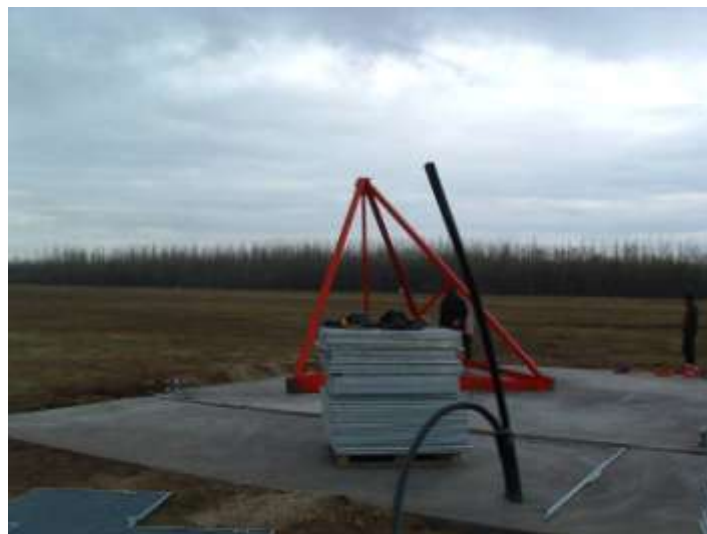
4. ábra. A lokátorantenna tornyának alaptestje
