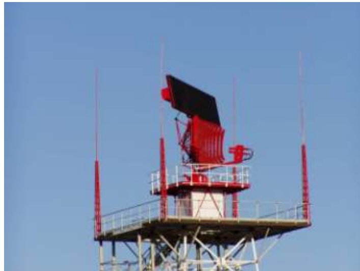
10. ábra. Lokátor, villámvédelmi felfogókkal
