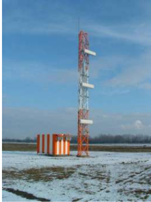
3. ábra. Siklópályaszög adó antenna és a hozzá tartozó konténer
