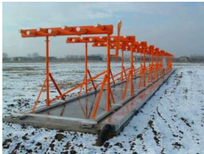
2. ábra. ILS berendezés irányszögadó antennasora vasbeton lemezalapon
