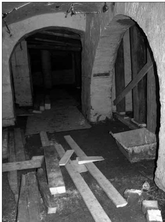
„A földpartos, boltíves pillérekkel alátámasztott pince végighúzódik az egész épület alatt (vagy talán tovább is?)”
