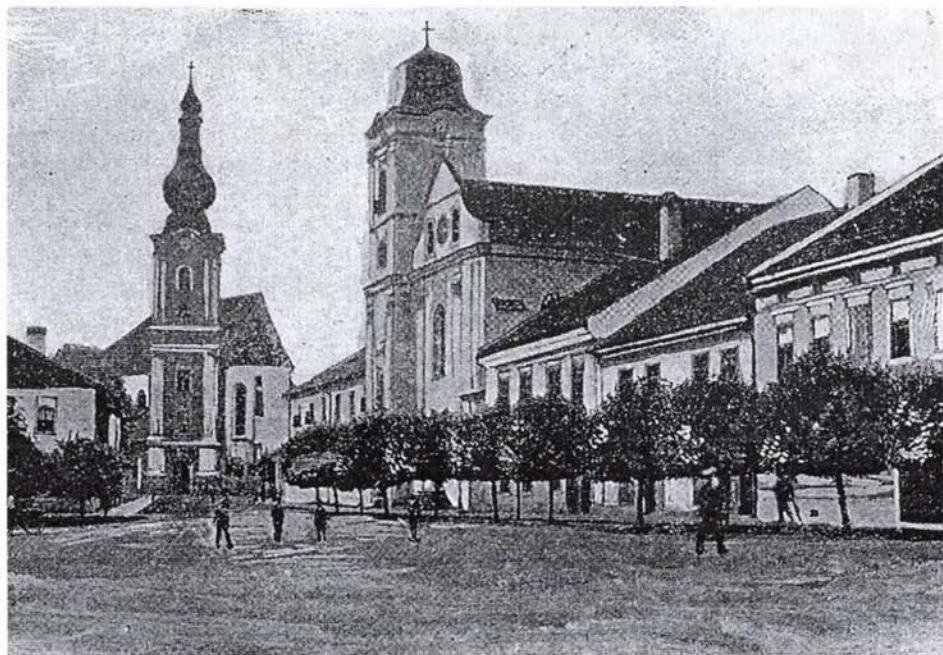
1. kép. A főtér északi házsora a püspöki székesegyházzal és a ferenciek templomával. A Kek nyomda épülete az utóbbi mellett található. Borovszky i. m. 125.
