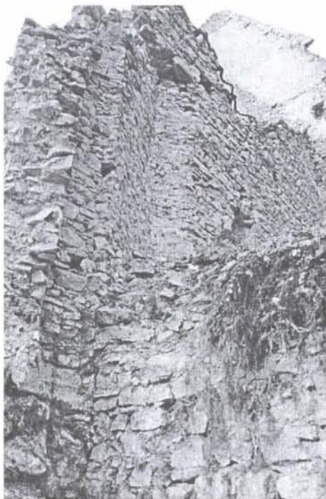
17. kép. A korai épület délkeleti sarkának lenyomata a szentély északi falán (fotó: Simon Zoltán)
