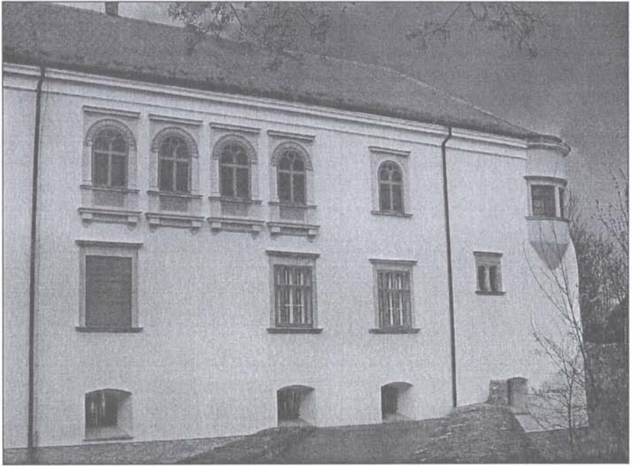
5. kép. A Perényi-szárny keleti homlokzata a Kőtar ablakaival
