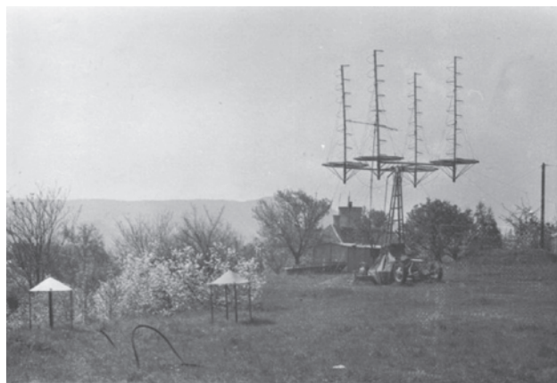
2. ábra. A mérésekhez használt négyes helix antenna mérőállásban a budapesti Ferenc-hegy tetején (forrás: Rádiótechnika 1968/11. sz. „80000 km áthidalása ultrarövid hullámokon”; szerző megjelölése nélkül)
