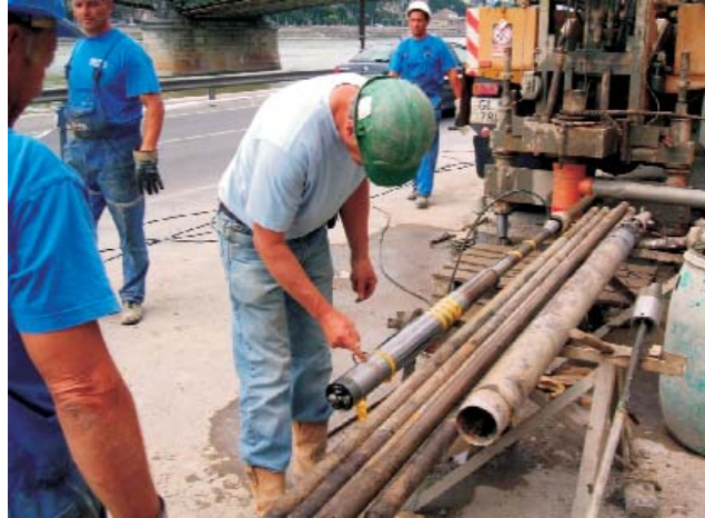
5. ábra. Önbefúró pressziométer
