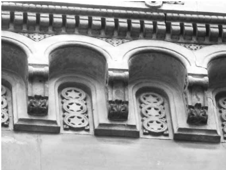
1. kép. Unger-átjáróház, Magyar utcai homlokzat részlete
