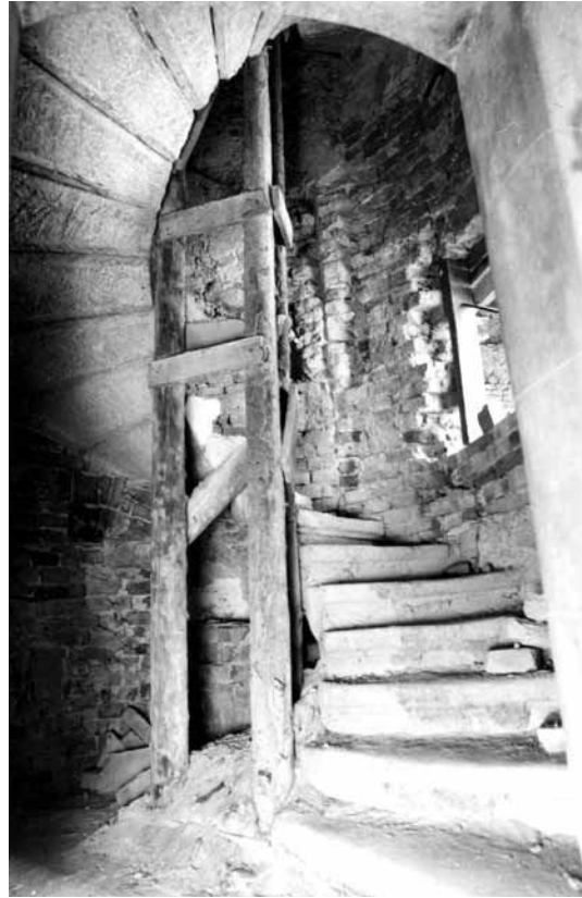
18. kép. A főépület és a keleti mellékszárnny csatlakozásánál Ybl által épített csigalépcső. Fotó: Mentényi Klára, 1998
