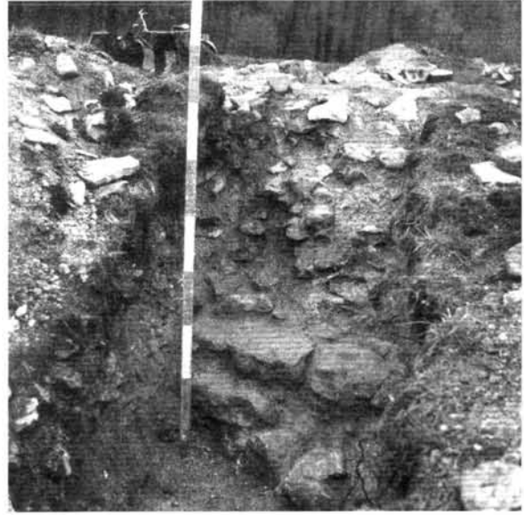
12. ábra. A szentély külső falrészlete és alapozása a 3. kutatóárokban (Fotó: Palágyi S. – Oszkó Zs.) Figure 12. A part of the outer wall of the apse and the basing in the third trial trench Photo: Palágyi, S. – Oszkó, Zs.)
